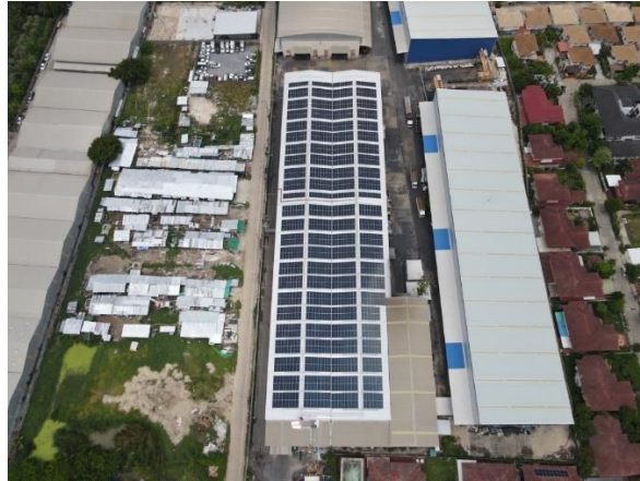
รูปที่ 1 โครงการ โซลาร์รูฟท็อป (Solar Rooftop) ระยะที่ 2 โรงงานสมุทรปราการ
